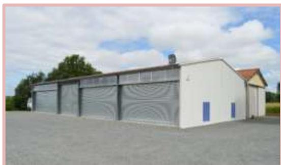
Le nouveau bâtiment municipal du Verger de l'Avenir vient d'être équipé de volets roulants, ce qui permettra la sécurisation de nos matériels mais aussi l'ouverture totale du préau en cas de besoin pour des manifestations. La fermeture en plaques translucides sur le haut de ces volets permet d'avoir de la clarté à l'intérieur malgré la fermeture totale du hangar.
