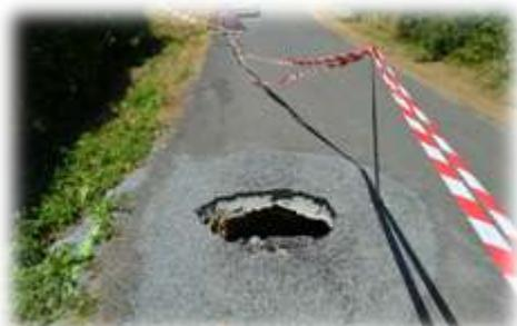
Après l'excavation dans la chaussée à l'étang des Forges, c'est maintenant à Chacord qu'un énorme trou s'est formé. La circulation n'a pas été fermée à cet endroit mais après un premier rebouchage ( plus 5 tonnes de gravillons ), le trou s'est de nouveau reformé. Des expertises sont en cours afin de
