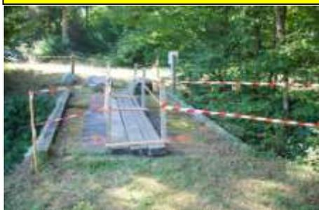
Une fuite d'eau très importante a fortement abaissé le niveau de l'eau sur l'étang des Forges et la passerelle qui sépare l'étang des Forges et l'étang du Moulin Haut est en très mauvais état. Eric notre employé a dû, provisoirement en limiter son accès en posant des poutres en travers afin de sécuriser le passage. Nous avons contacté l'ONF qui va faire prochainement le nécessaire afin que tout rentre dans l'ordre.
