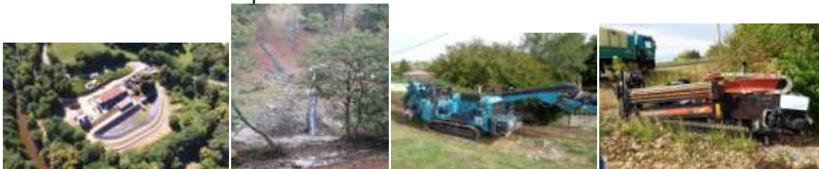
Vue station Pont château Travaux cana sur Cornut. Travaux cana à la trancheuse et par fonçage sur Clermont
